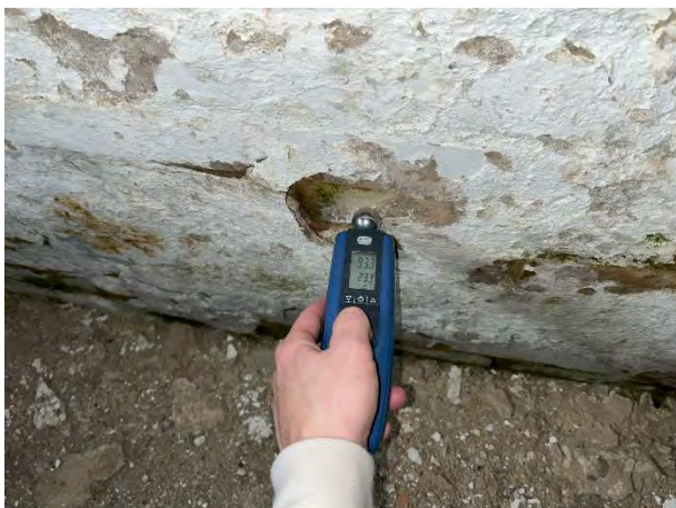
Fugtmåling af kældervæg
