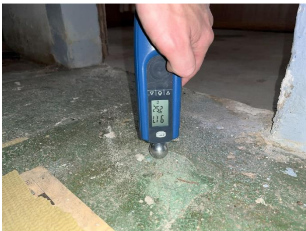
Fugtmåling af gulvbeton, kælder
