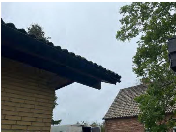
Tagrende ved det vestlige hushjørne
