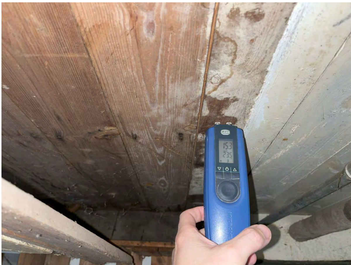
Fugtmåling af loft/gulvbrædder, kælder
