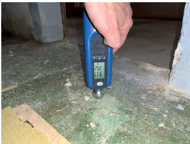
Fugtmåling af gulvbeton, kælder
