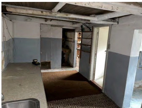
Skimmelprøve nr. 3, kælder
