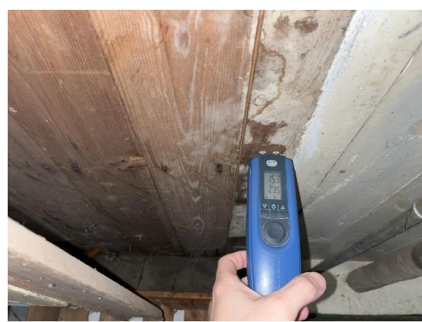
Fugtmåling af loft/gulvbrædder, kælder
