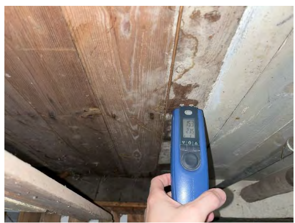
Fugtmåling af loft/gulvbrædder, kælder
