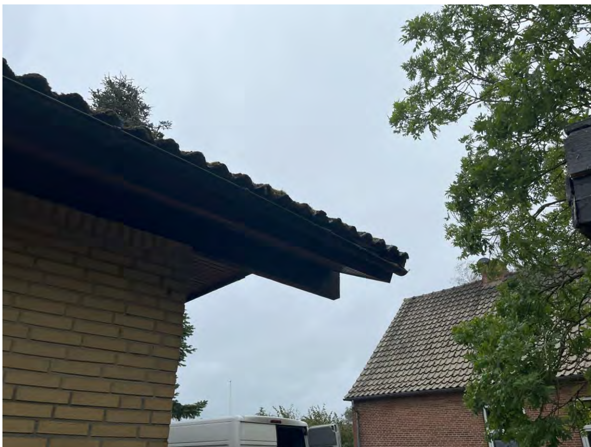
Tagrende ved det vestlige hushjørne
