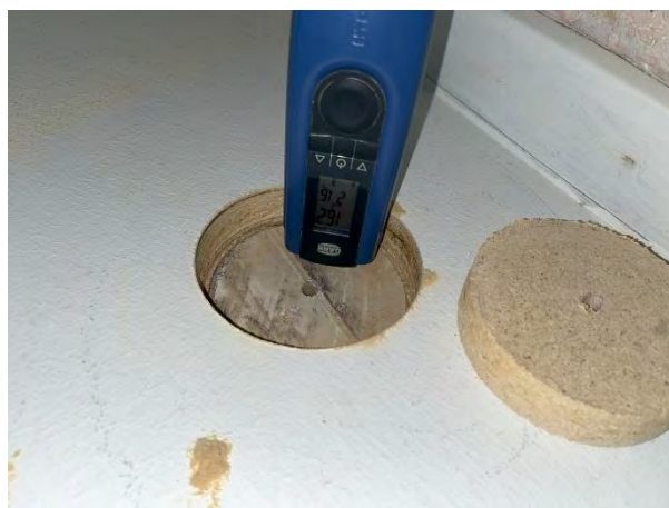
Fugtmåling af gulvbrædder under gulvspån, prøvested nr. 5, soveværelse
