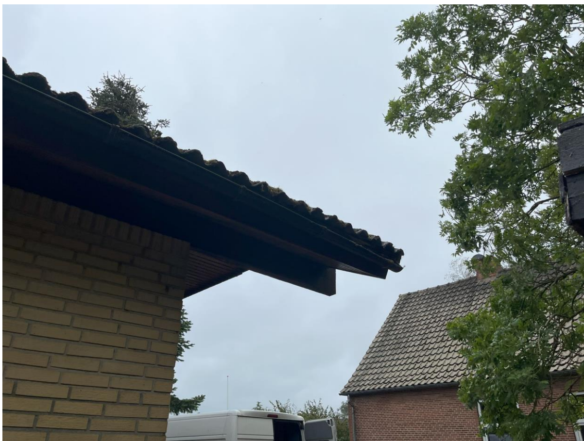
Tagrende ved det vestlige hushjørne
