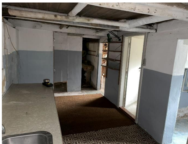
Skimmelpróve nr. 3, kælder
