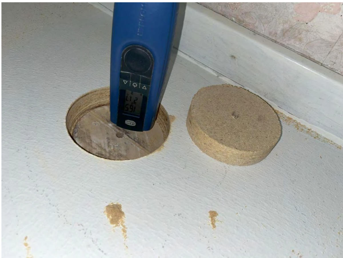
Fugtmåling af gulvbrædder under gulvspån, prøvested nr. 5, soveværelse
