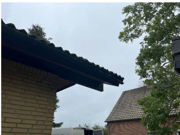
Tagrende ved det vestlige hushjørne
