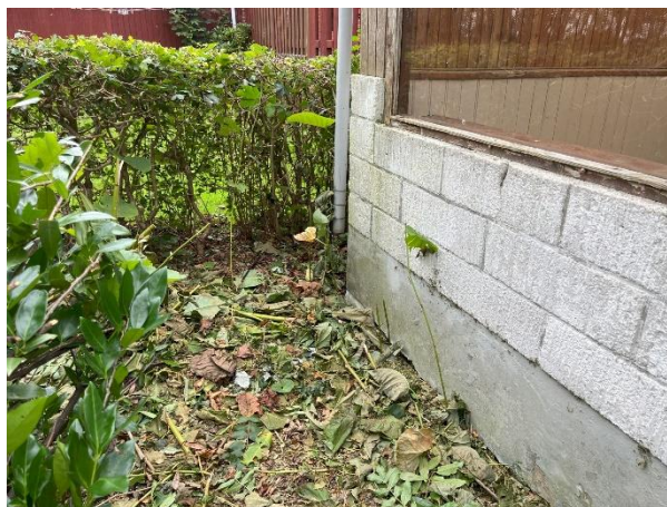
Tagvand ledes ned på terræn
