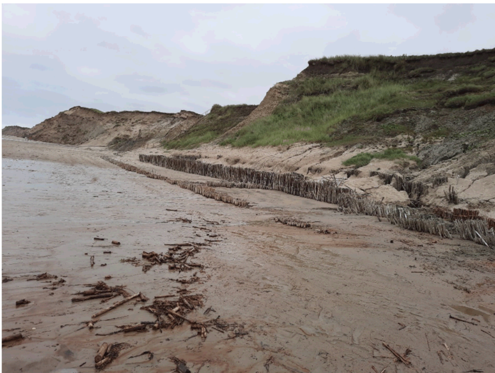
Figur 4: Løse grene fra pilebundterne ses på stranden foran pileanlægget i Nr. Lyngby.
