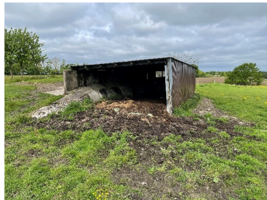
Bygning 9, læskur bygget ind i stejlt skrånende terræn og på front af betonbunker, som herved skjules
