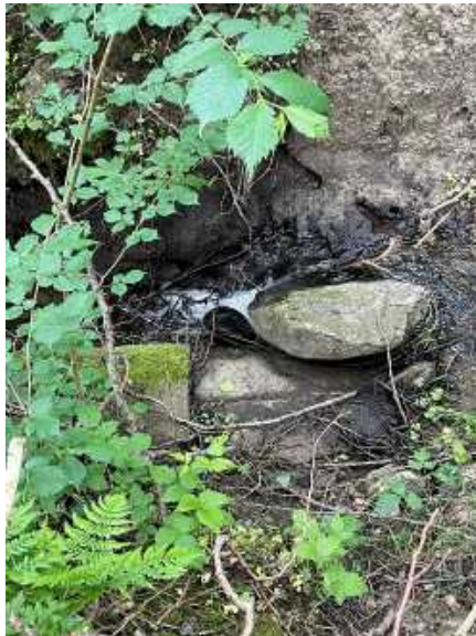
Start af strækning indeholdende stenspærringer.
