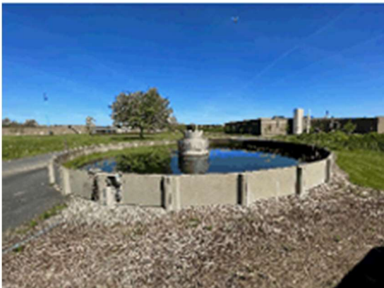
Figur 1. Processpildevandstank på Sæby Fiskeindustri's rensningsanlæg
