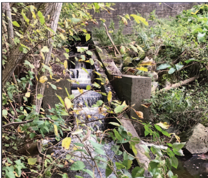
Figur 3: Billede af spærringen AAL-589 (fisketrappe)
