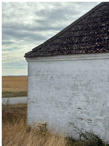
Gesims i facade
