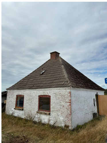
Bygning set fra sydvest
