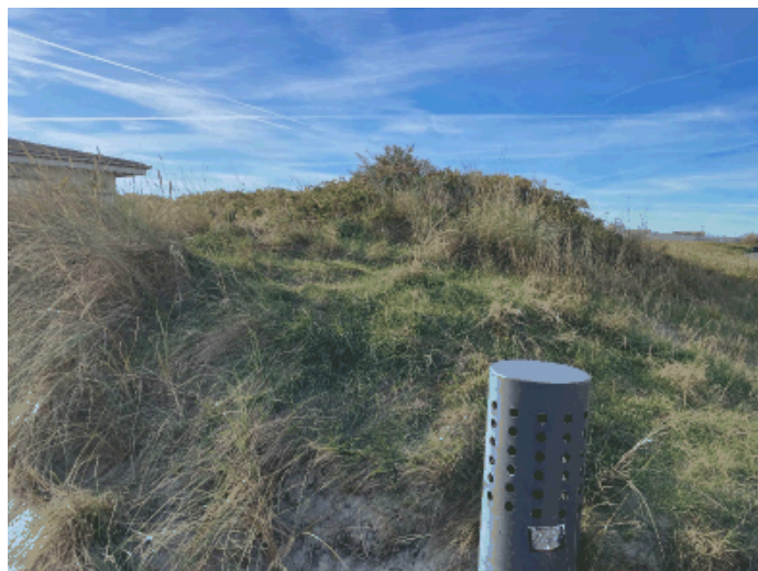
Foto 2. klitten som bliver midlertidig opgravet for at fjerne den gamle septiktank. Det grå rør er udluftningsrør.
