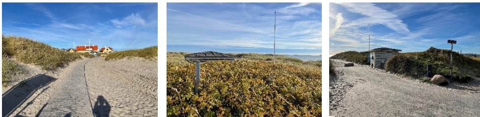
Den eksisterende toiletbygning set fra hhv. sydøst, vest og nord. Molokkerne anes foran den nuværende toiletbygning.
