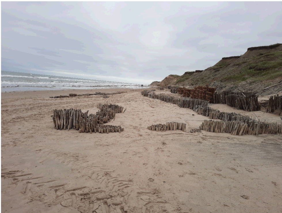
Figur 7: Pileanlægget ved Nr. Lyngby. Det fremgår, at der for nylig er flyttet sand fra forstranden om bag pilebundterne og nye pilebundter er blevet tilført. Pilebundterne har forskellig grad af tildækning.
