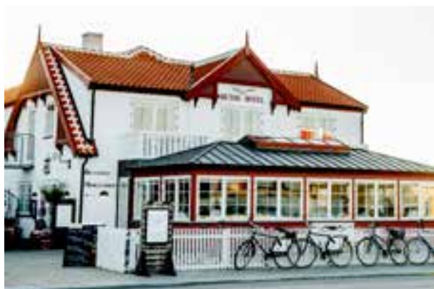
VELBEVARET BYGNINGSARV OG STÆRK BYIDENTITET
