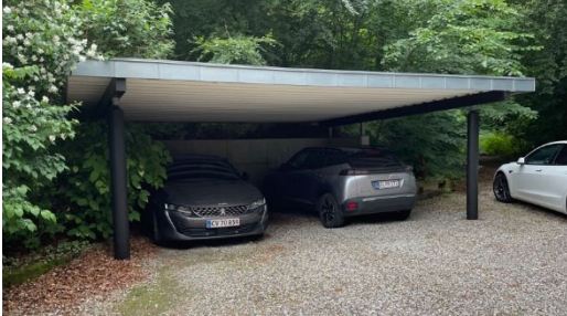
Bilag: Foto af carport, bygning 5 i BBR
