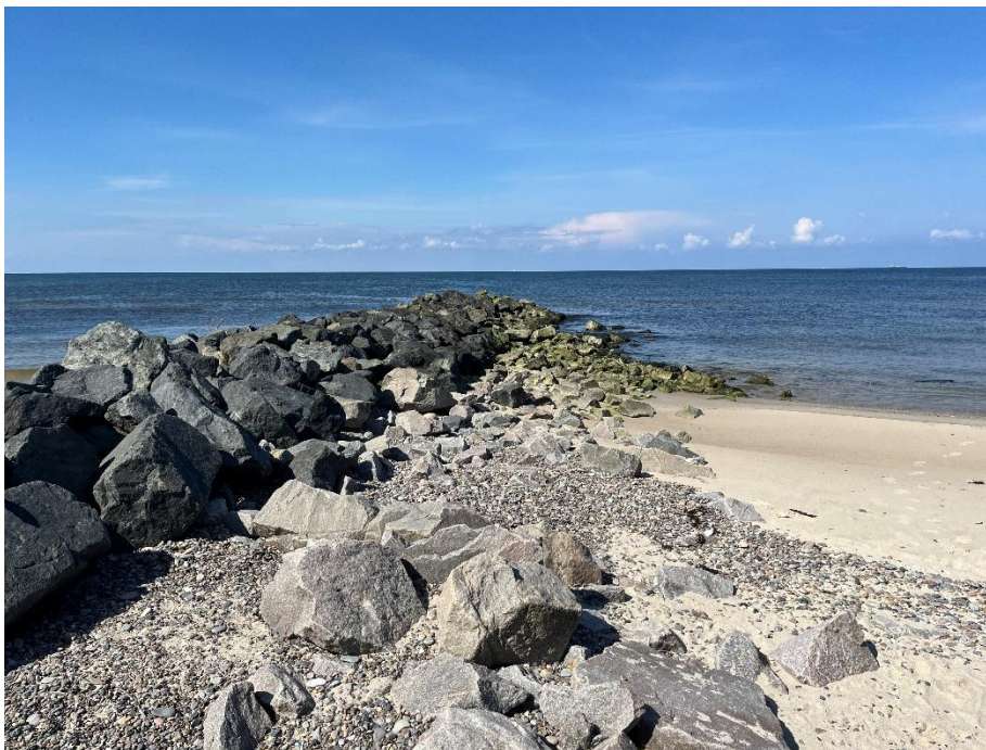
Figur 8: Højde 8/78 med mange sten på stranden omkring høfdeskaftet, specielt på den nordlige side og langt ind på stranden samt udtrukne dæksten fra høfdehovedet.
