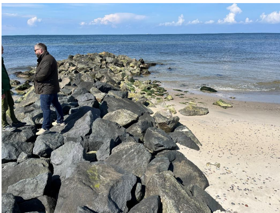
Figur 6: Høfde 10/78 med sten trukket ud fra dæklaget langs høfdeskaftet omkring vandlinjen og omkring høfdehovedet.
