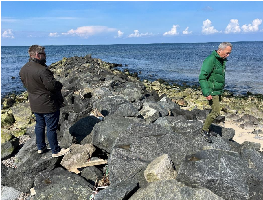
Figur 7: Højde 9/78 med mange sten på stranden omkring høfdeskaftet, specielt på den nordlige side.
