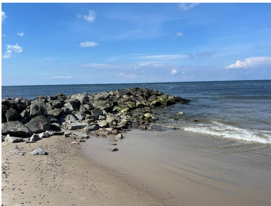
Figur 4: Høfde 12/78, sten udtrukket af aflejret på høfdeskæftets nordside og delvist udjævnet høfdehoved.
