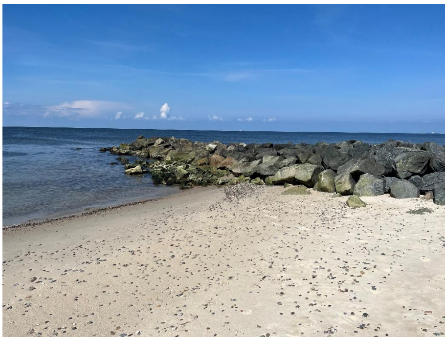
Figur 9: Høfde 7/78 med sten på stranden på både nord- og sydside omkring hofdeskafet i området omkring vandspejlet samt dæksten fra hofdehovedet der er aflejret foran hofdehovedet.
