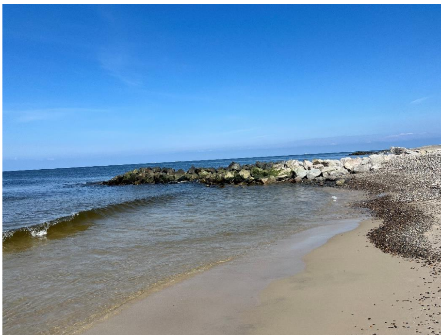
Figur 11: Højde 5/78 med tydelig lunke umiddelbart bag højdehovedet og en del udtrukne sten langs højdeskaftet.
