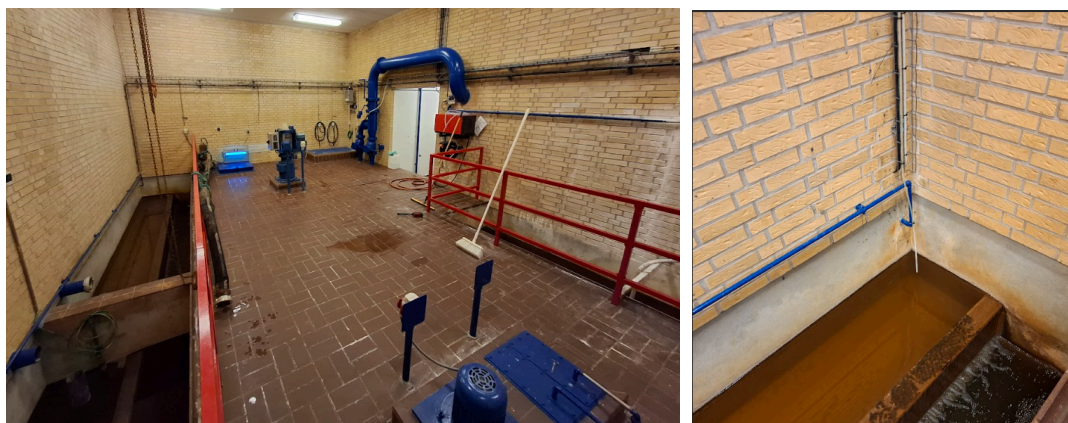
Figur 3: Placering af doseringspunktet er venstre bagerste hjørne i reaktionsbassinet, hele lokalet ses til venstre og selve doseringspunktet ses til højre.
