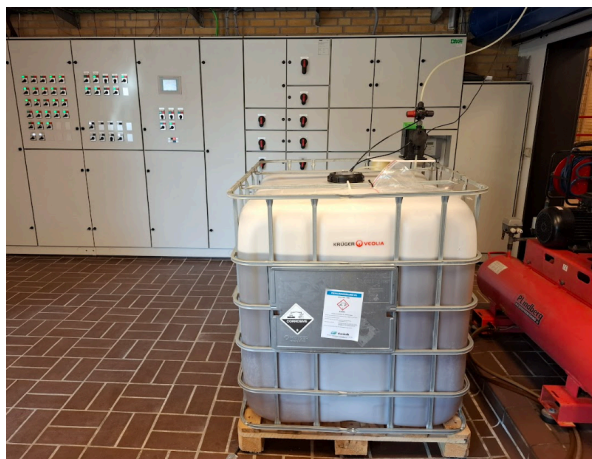
Figur 2: Princip for forsøgsopstillingen med dosering af PAC til vandbehandlingen på Læsø Vandværk (venstre) og den opstillede kemikalietank med doseringspumpe (højre).
