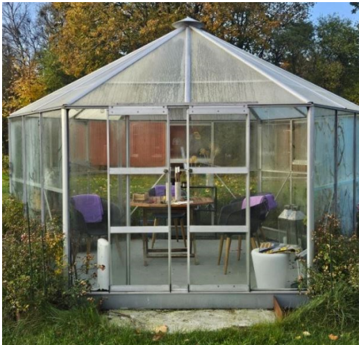
Foto af bygning 8, Fritliggende udestue (pavillon)
