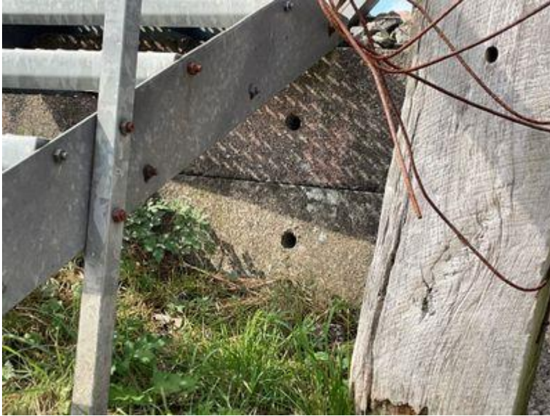
Figur 3-25 Mindre huller i beton.
