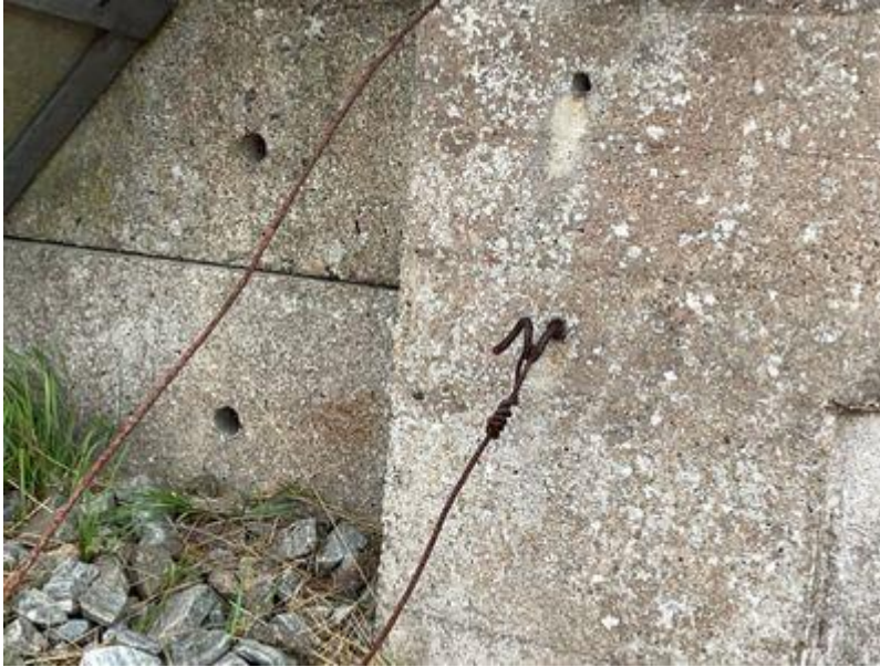
Figur 3-27 Mindre huller i beton.
