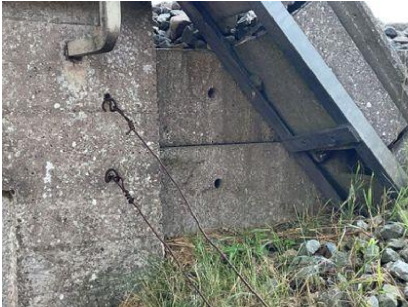
Figur 3-28 Mindre huller i beton.
