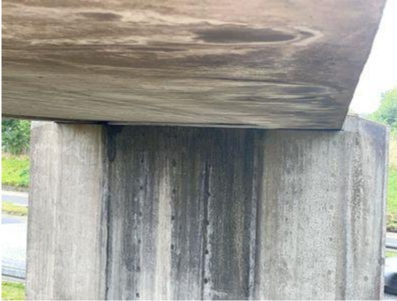
Figur 3-15 Bropille med en gennemgående sprække, ca. 10 cm høj og aflang. Det vurderes at der kan være et potentielt dagsrast her.
