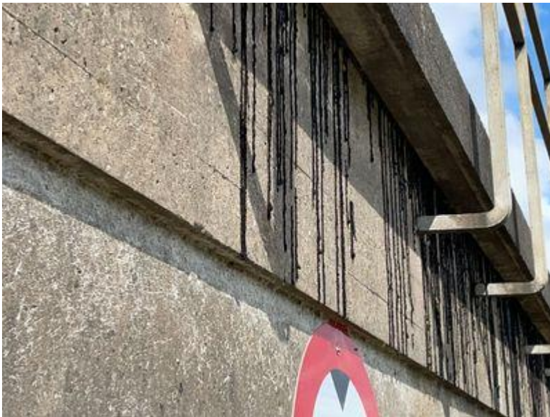
Figur 3-26 Smal sprække mellem bro og rækværk, dybden af sprækken er ca. 2 cm.
