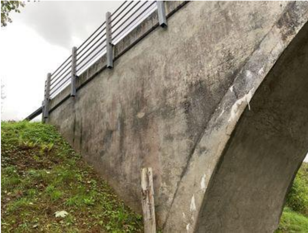
Figur 3-31 Rækværket på broen holdes oppe af hule metalpæle.
