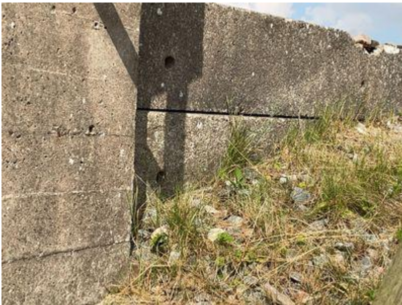
Figur 3-24 Mindre huller i beton.
