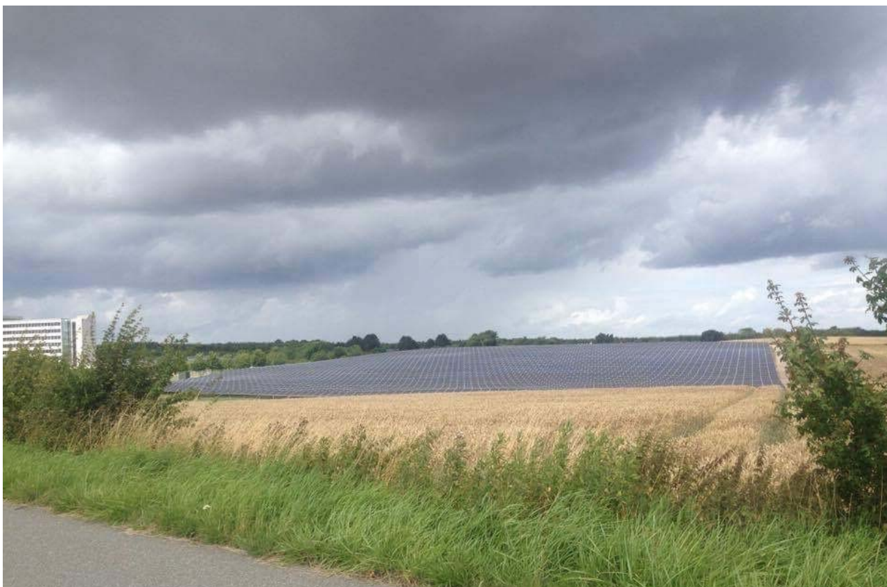
Figur 4: Solceller på skrånende terræn uden afskærmende beplantning ved Danfoss
