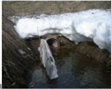
Indløb til rørbrø.
