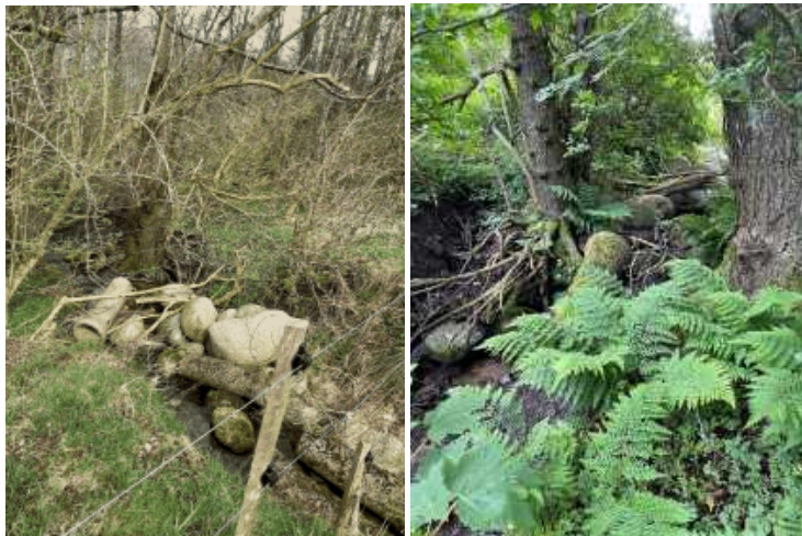
Start af strækning indeholdende stenspærringer.
