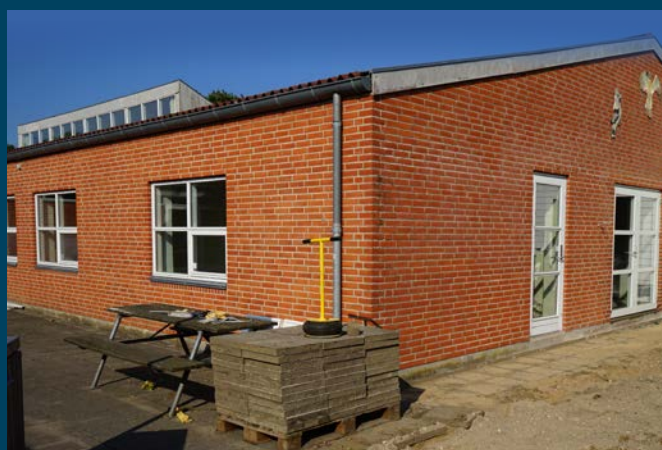
Ravnshøj Skole, ombygning.
