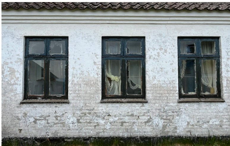
Dato: 11-05-2026 Type: Facade mod øst Stikord: Originale vinduer
