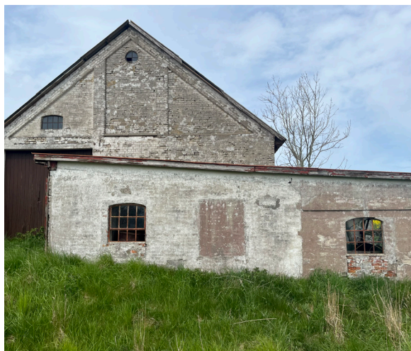
Dato: 11-05-2026 Type: Gavl og tilbygning mod syd Stikord: Slid i murværk
