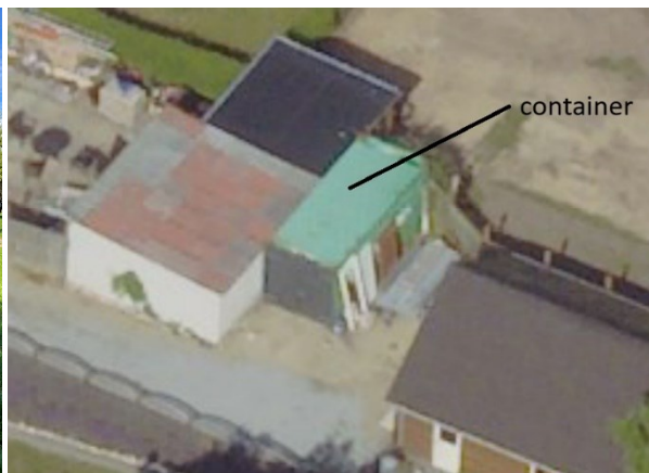
Vedlagt: Foto af container
